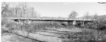
Общий вид моста в/у Тарова на в/д Шаблово – Парголово в Приморском крае. Схема моста 6х2+12х2-6х2. Третье пролетное – сталежелезобетонное пролетное строение с предварительно напряженными СПА балками.
